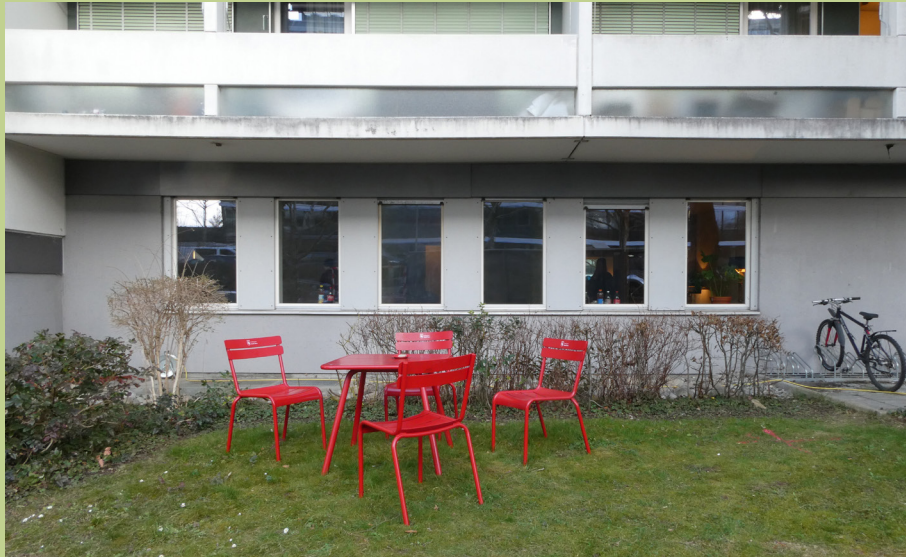
Temporäre Sitzgelegenheiten vor dem Gebäude © Bureau Giacometti
